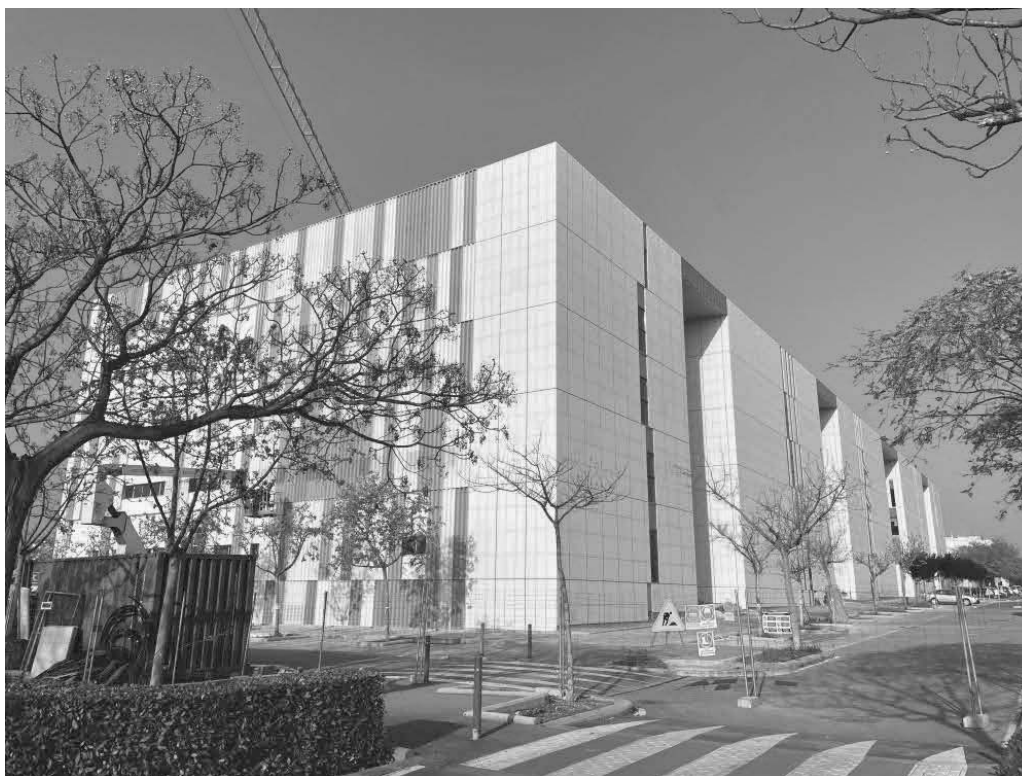
Figura 40: Estado constructivo de la Facultad de Ciencias de la Salud en marzo de 2021.
