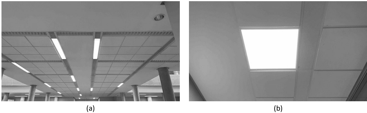
Figura 40: Sustitución de luminarias fluorescentes por tecnologías led. (a) Sistema de iluminación basado en tubos fluorescentes que se sustituye. (b) Nuevas placas con iluminación led.
