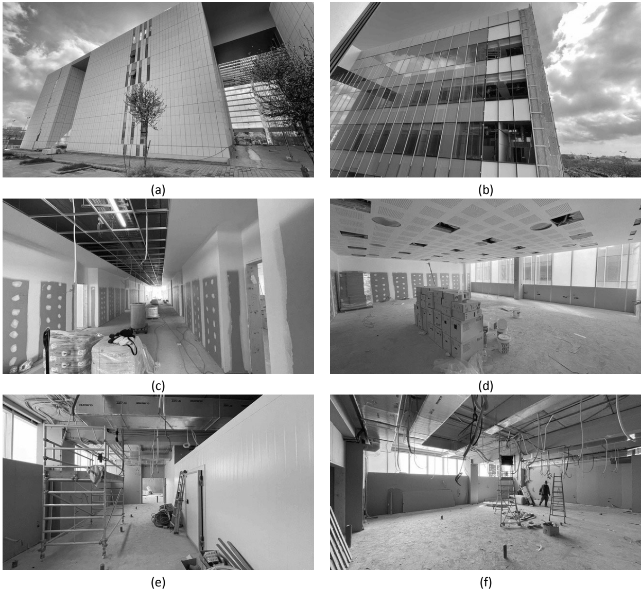
Figura 44: Estado de las obras de la Facultad de Ciencias de la Salud en febrero de 2022. (a) y (b) Exterior. (c) y (d) Pasillos y aulas del módulo docente. (e) y (f) Espacios de la sala de disección.
