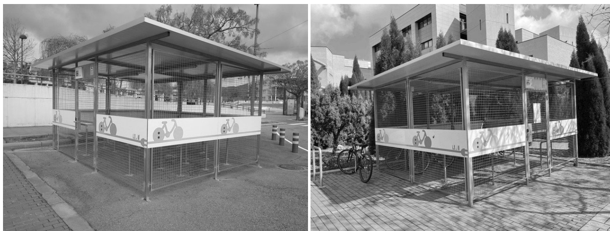
Figura 42: Aparcamientos cerrados para bicicletas que han entrado en funcionamiento en 2021. Disponen de alimentación eléctrica para la carga de baterías de vehículos de movilidad personal.
